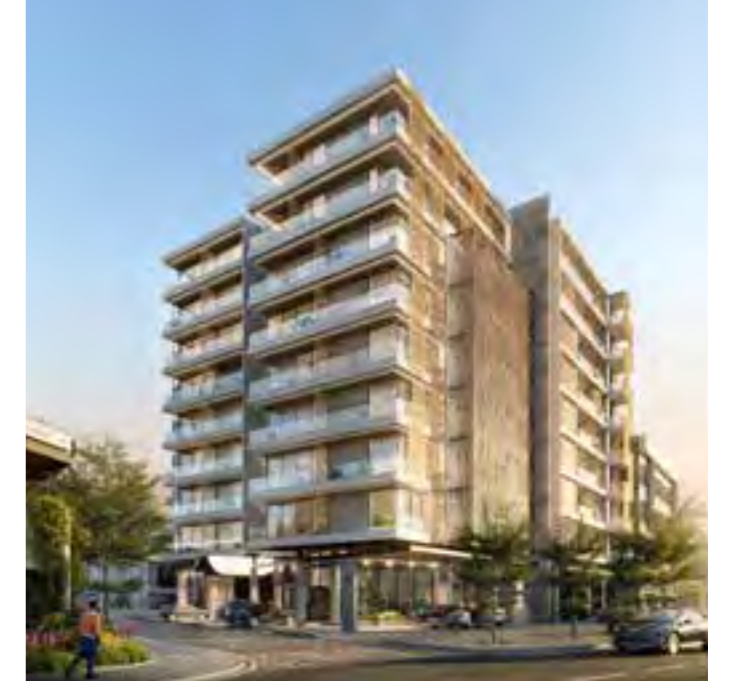
Vue du projet Résidence Siki, à Dakar
