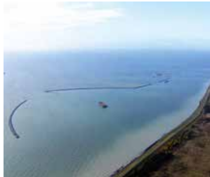
DANEMARK Démarrage des travaux du tunnel du Femern, le plus long tunnel immergé routier et ferroviaire du monde (17,6 km), qui reliera le Danemark et l'Allemagne.
