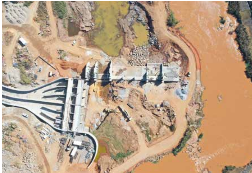
MADAGASCAR Sogea-Satom participe à la construction du barrage hydroélectrique de Farahantsana sur la rivière Ipoka, à 30 km au nord-ouest de la capitale, Tananarive.
