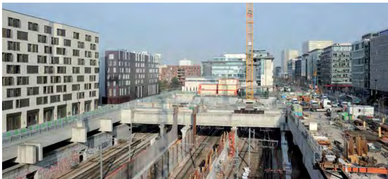
Couverture des voies ferrées à Austerlitz-Sud.
