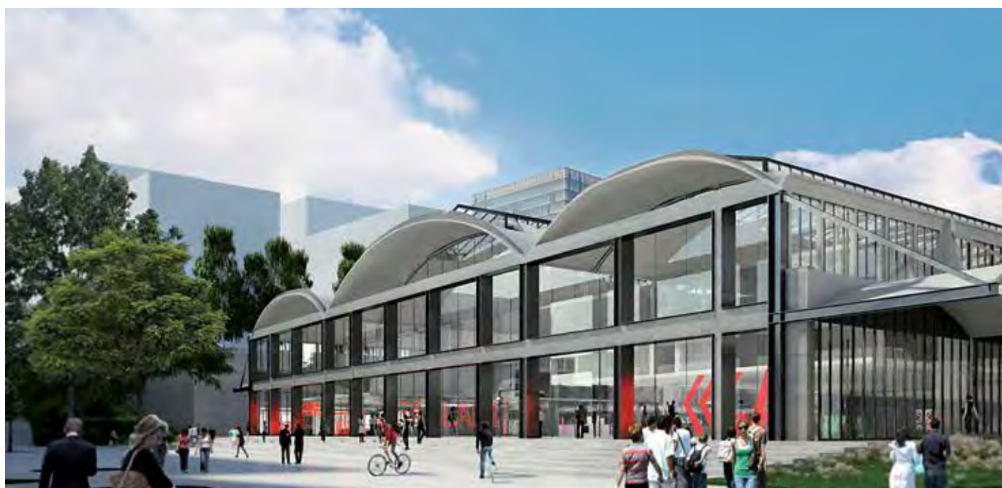
La halle Freyssinet sera achevée fin 2016. Architecte : Jean-Michel Wilmotte.
