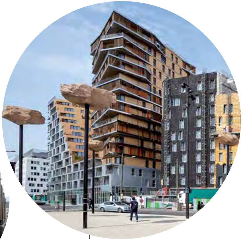
À Masséna-Bruneseau, un nouveau quartier sort de terre.
