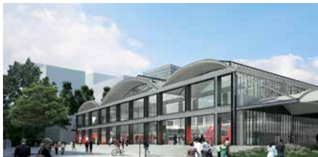
Future Cité du numérique, la Halle Freyssinet réaménagée sera dédiée aux emplois de demain.
