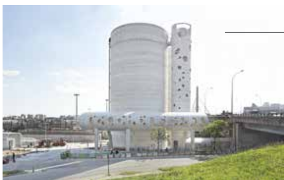
La nouvelle installation de Ciments Calcia, parfaitement intégrée dans la ville, permet également le démarrage de l'aménagement de Bruneseau.
