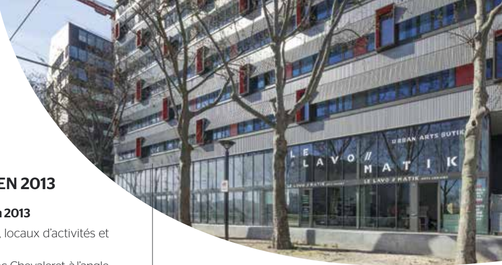
Sous la promenade plantée, dans le quartier Tolbiac de Paris Rive Gauche, de nouveaux commerces s'installent.
