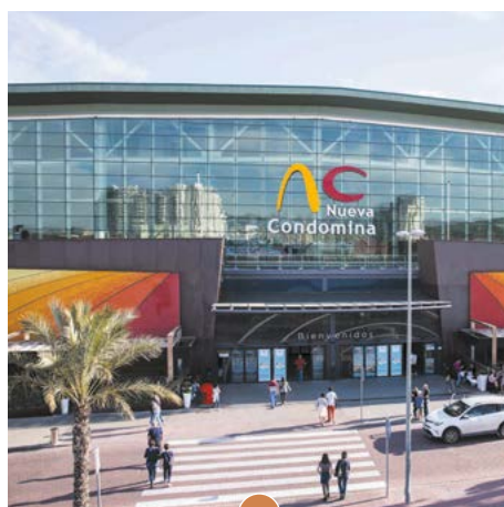
Nueva Condomina Murcia - Espagne
