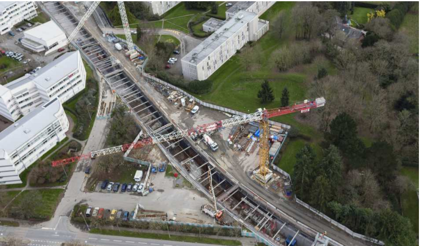
Tranchée couverte métro de Rennes (35)
