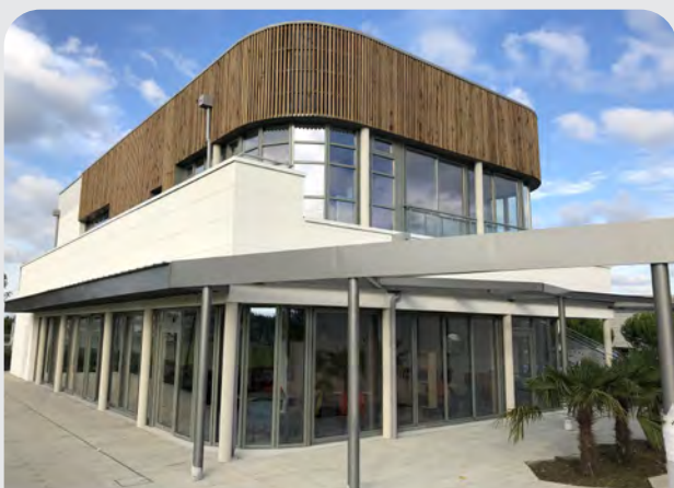
Le bâtiment dédié aux collaborateurs
