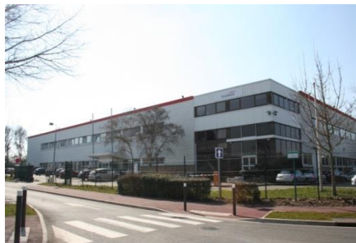
Immeuble mixte composé de bureau et d'activité, Buc (78)
