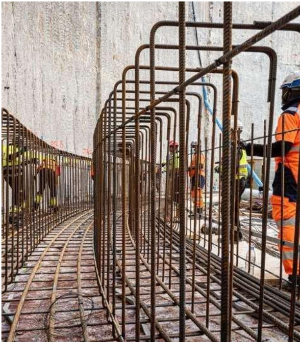
Creusement à l'Ouvrage Bel-Air
