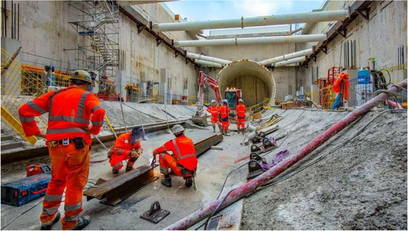
Gare Aulnay. Ripage du tunnelier Houda dans la boîte souterraine
