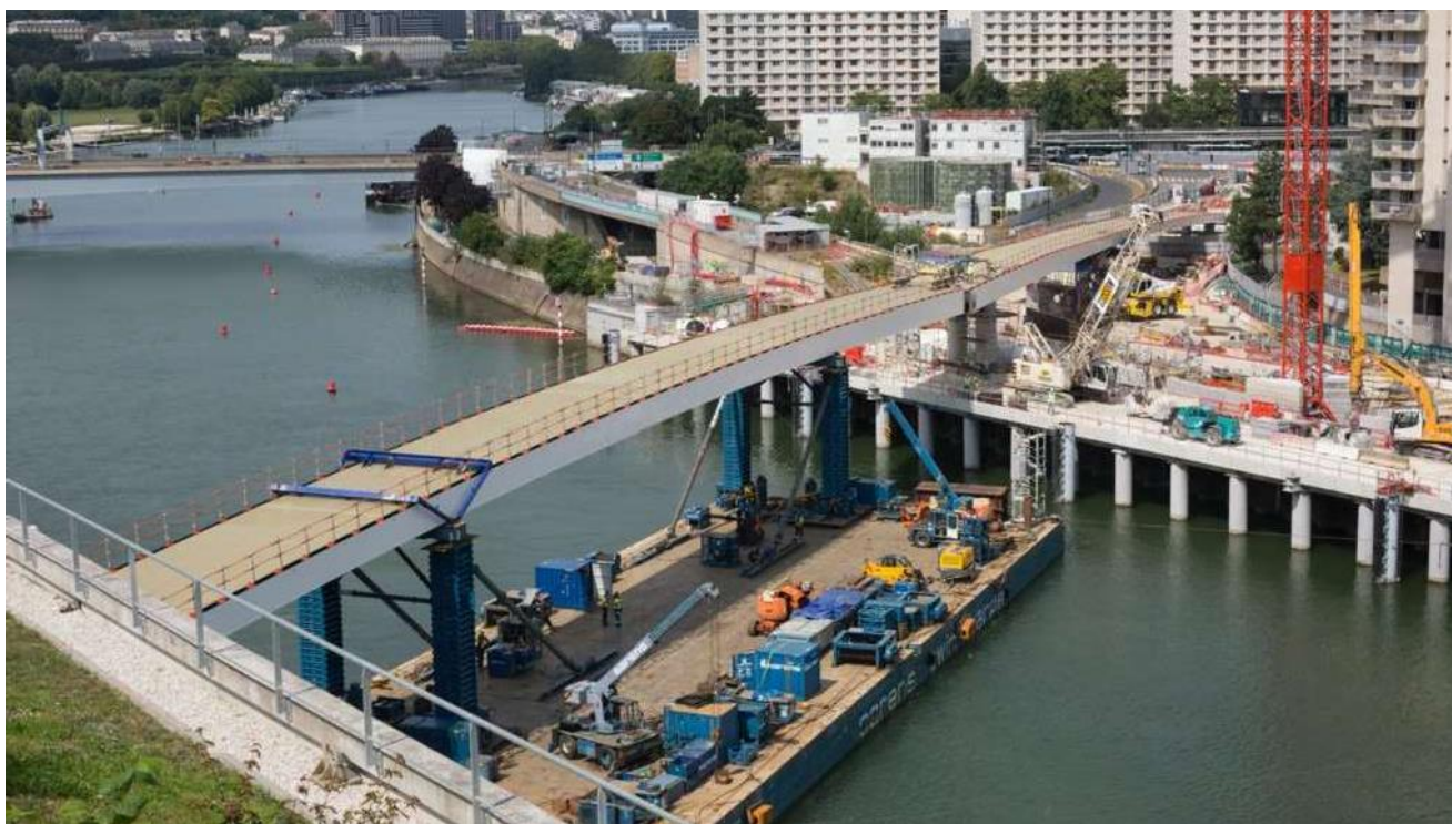
Gare de Pont de Sèvres. Pose du tronçon 3 de la passerelle
