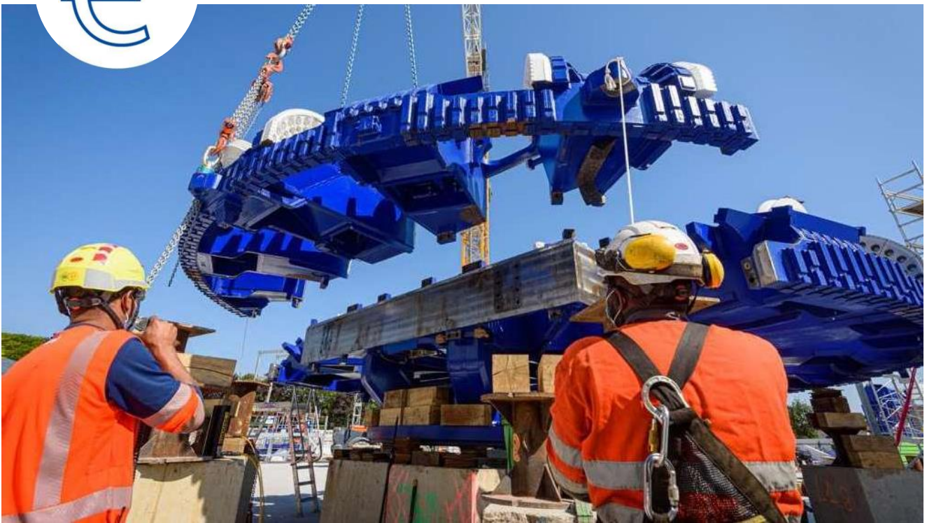
Puits Maréchal Leclerc à Massy. Le chantier en cours
