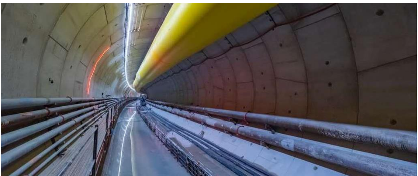
Gare du Vert de Maisons à Maisons-Alfort. Avancement des travaux
