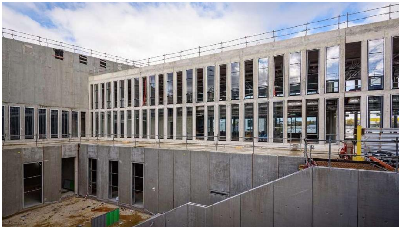
Centre d'exploitation de Champigny. Pose de la façade vitrée extérieure
