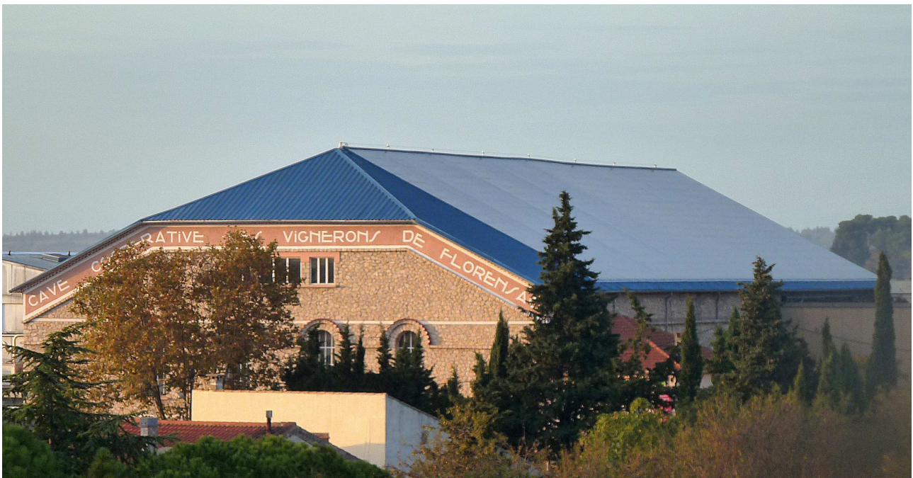
Photo de la cave coopérative Vinipolis à Florensac (Hérault) - Copyright : Aérowatt
