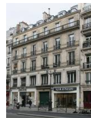
Rue de Rivoli et rue du Roule Mixte - 1 887m 2 Acquis en 2006 Locataires divers
