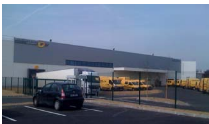
Locaux d'activités à Vitry (94) 650 m 2 de bureaux et 2 030 m 2 d'activité Construit en 2009 et livré à La Poste en janvier 2010
