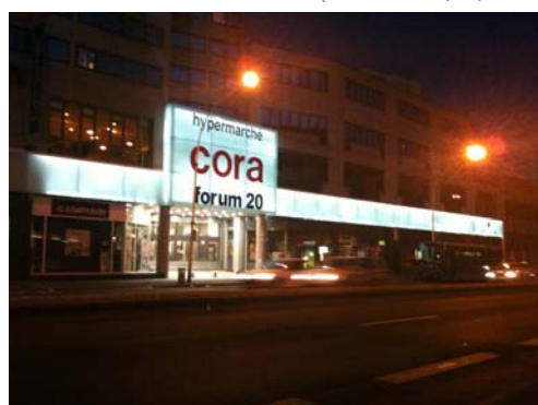
2010 : remplacement de la façade de Forum 20, Arcueil (94), après rénovation de la galerie en 2009
