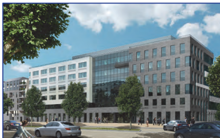
Immeuble de bureaux de 11 000 m 2 à Nanterre (92) en cours de construction
