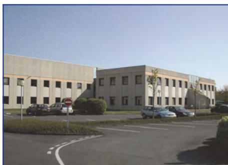
Boulevard de Beaubourg, Croissy-Beaubourg (77) Acquis le 27 avril 2007
