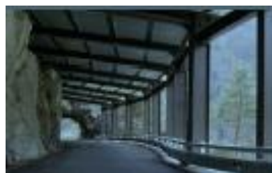
Tunnel routier de protection
