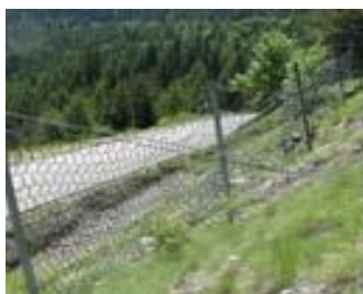
Route protégée par un filet pare-pierre
