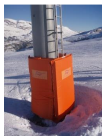
Matelas de protection de pylône
