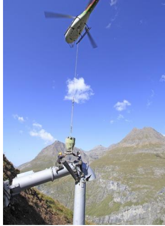
Hélicoptage de composant pour installer un déclencheur d'avalanche
