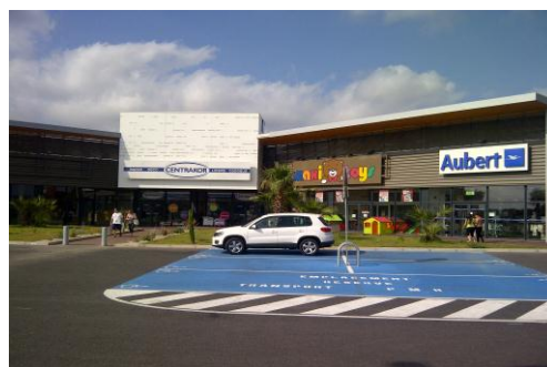
Zone commerciale en extension, Rivesaltes (66)
