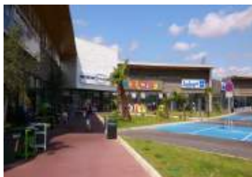
Zone commerciale en extension, Rivesaltes (66)
