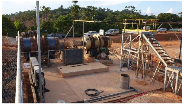
Le 1 er des deux broyeurs secondaires est en place
