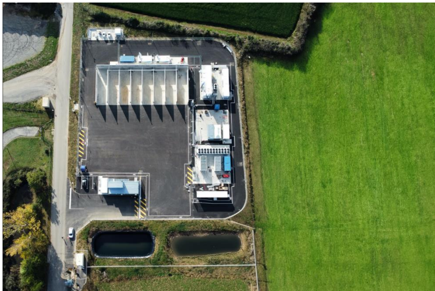
Lhyfe et Source Galileo travailleront ensemble à la mise en place de sites de production d'hydrogène vert au Royaume-Uni, à l'instar de l'installation récemment inaugurée par Lhyfe en Occitanie. (crédit : Lhyfe) Plus de photos HD ici
