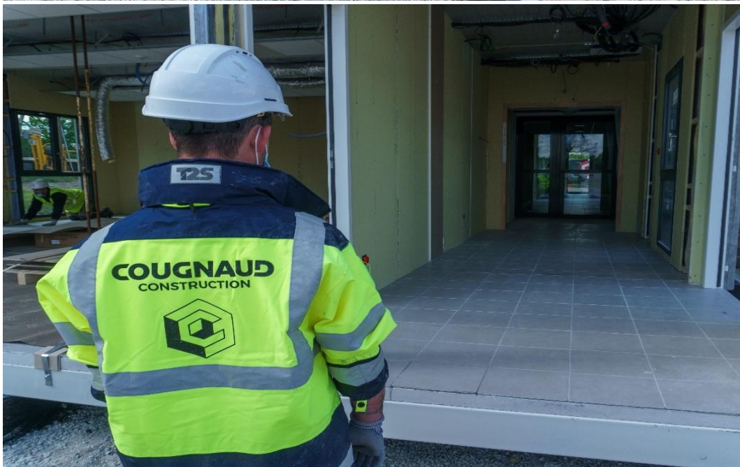
Montage du bâtiment équipé de dalles en béton décarboné Hoffmann Green
