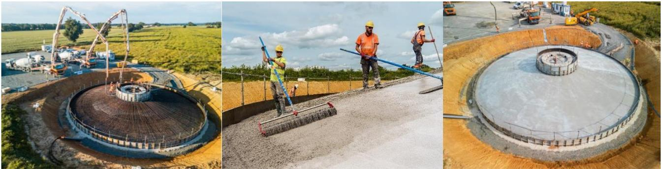
C'est sur le chantier du parc éolien de la Plaine des Moulins à Jazeneuil (Vienne), que le Groupe VALOREM a souhaité qu'Hoffmann Green et ses partenaires réalisent une première mondiale : le coulage d'une fondation d'éolienne avec un volume de béton décarboné de 630 m<sup>3</sup>. L'utilisation d'un béton décarboné a permis de réaliser un gain de 33 tonnes de CO<sub>2</sub>, soit 32% de moins qu'avec un béton traditionnel et ce sans aucun changement de méthode pour le chantier.
