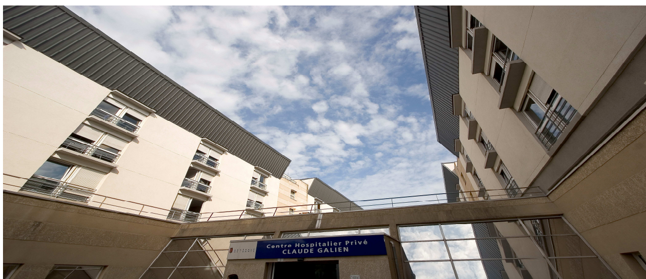
« Centre Hospitalier Privé Claude Galien », Quincy-sous-Sénart - Exploité par Générale de Santé.
