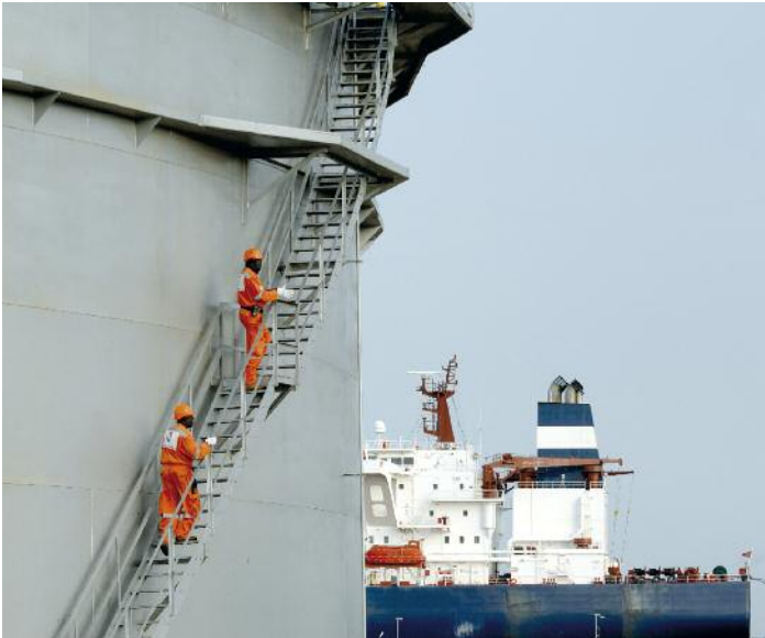
Bac de stockage au terminal du Cap Lopez
