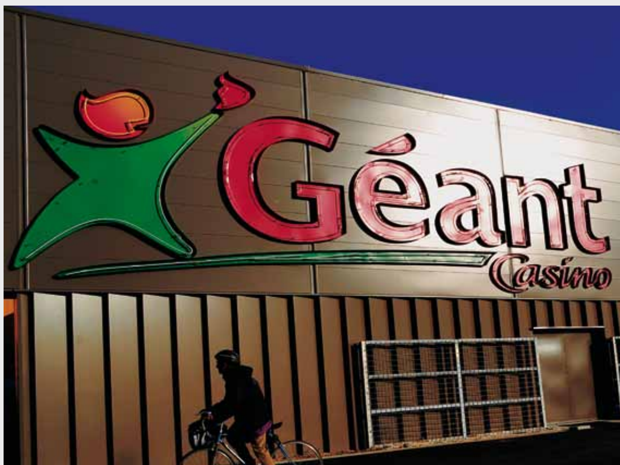
GÉANT CASINO, Arles Fourchon, France
