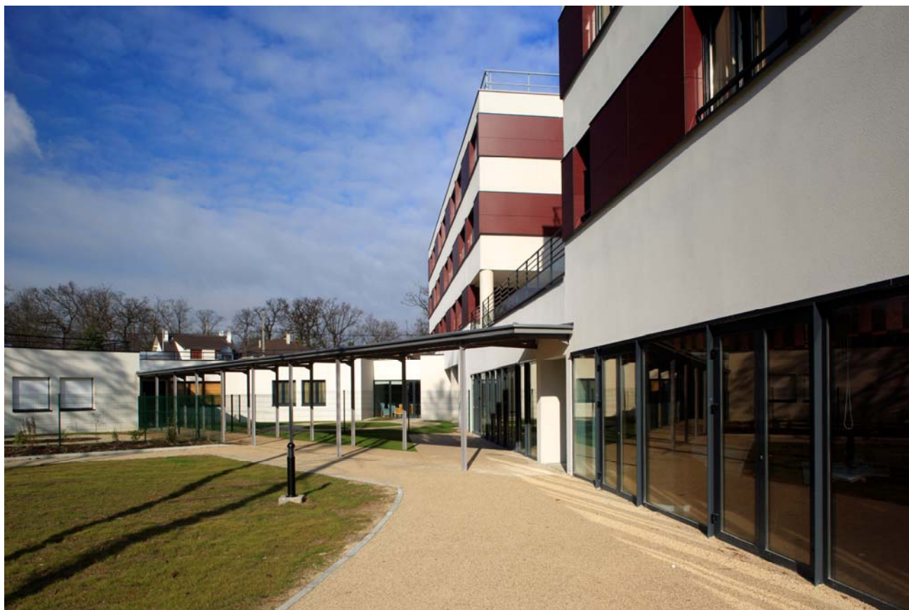
EHPAD de Villemomble (Seine-St-Denis) – exploité par Medica
