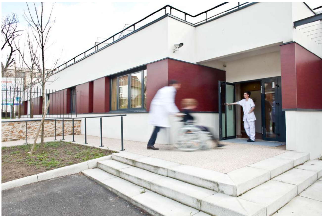
EHPAD de Villemomble (Seine-St-Denis) – exploité par Medica
