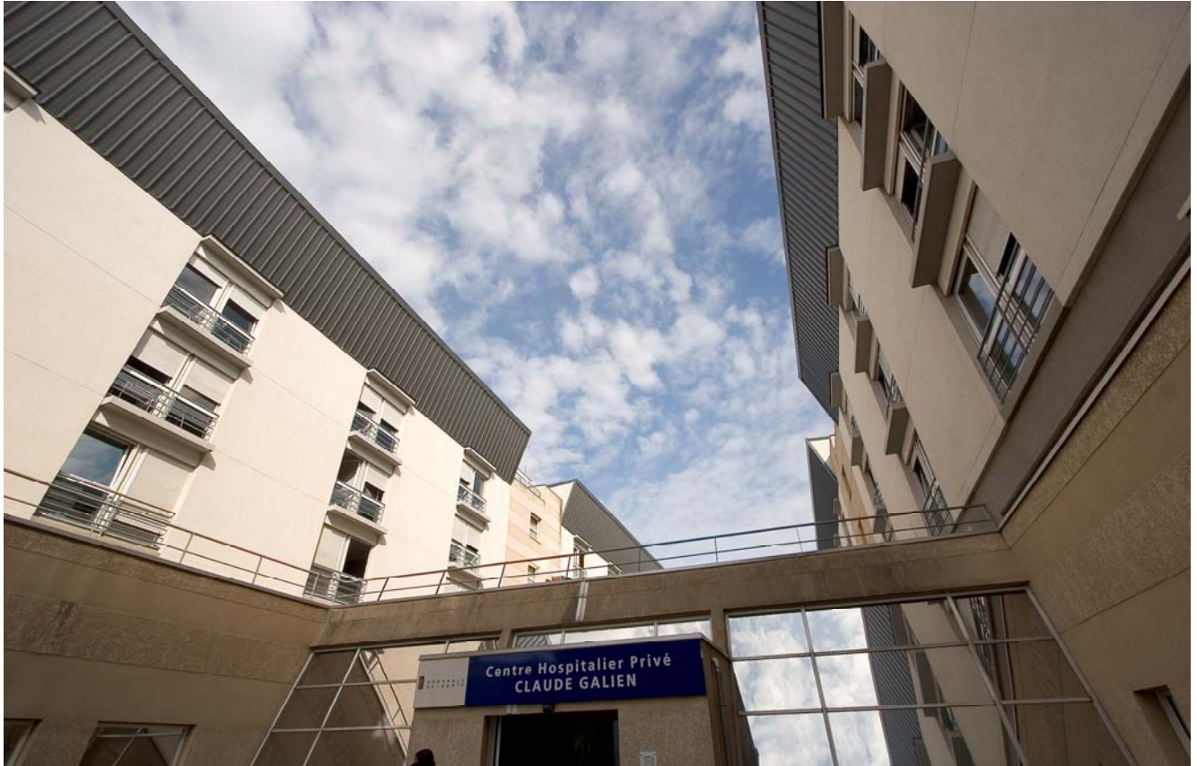
Centre Hospitalier Privé Claude Galien, Quincy-sous-Sénart (91) – Exploité par Générale de Santé
