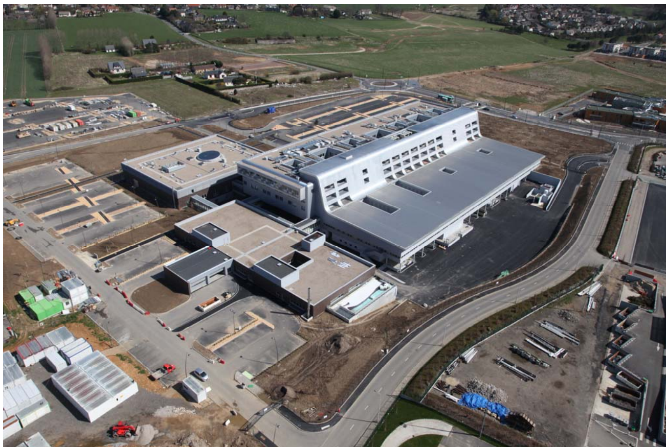
Hôpital Privé de l'Estuaire, Le Havre (Seine-Maritime)
