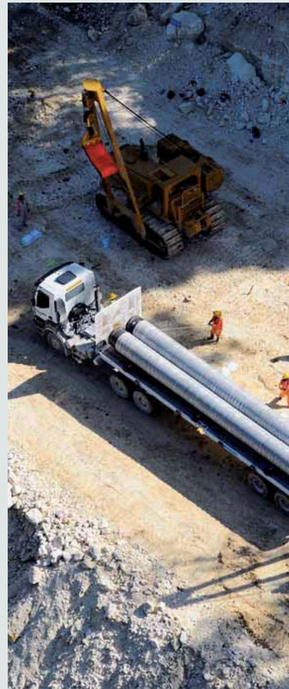
Projet « PNG » (Papouasie – Nouvelle-Guinée) – Acheminement et bardage des tronçons de pipeline.
