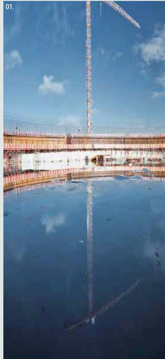
01. Construction des parois d'un réservoir cryogénique.
