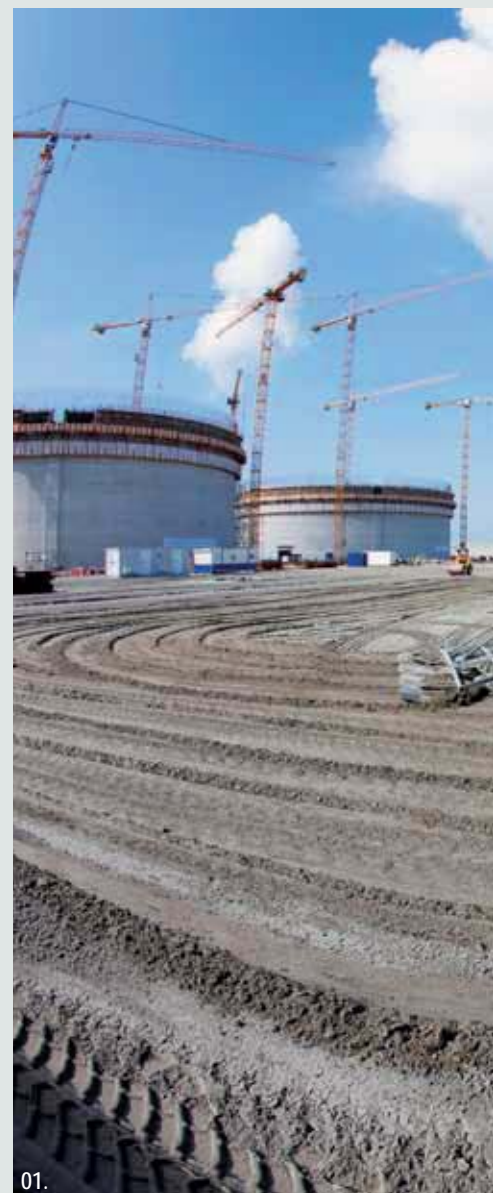
01. Projet « GATE LNG » (Pays-Bas) – Terrassement autour des réservoirs.
