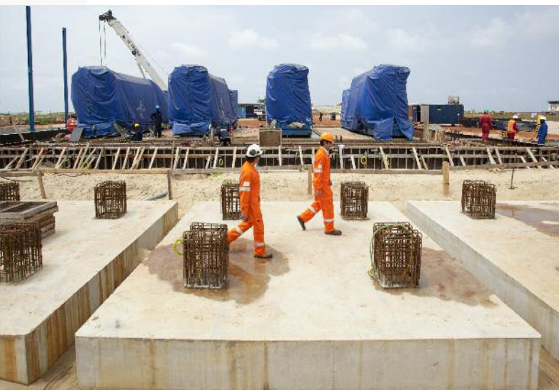
Chantier de construction de la centrale électrique de PG2 ▼
