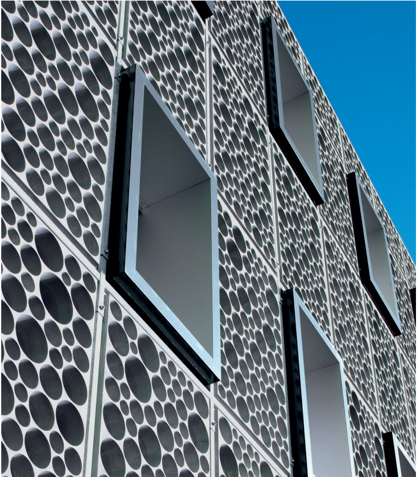
▲ La façade d'un bâtiment du groupe Swatch, à Cormondrèche, réalisée en béton fibré à ultra hautes performances (BFUP), un béton six fois plus résistant que les bétons courants.
