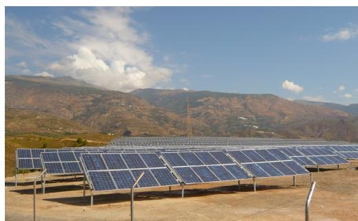
La centrale, implantée à côté de la ville d'Orgiva en Andalousie sur un terrain d'environ 6 hectares, dispose d'une puissance de 2,3 MWc.
