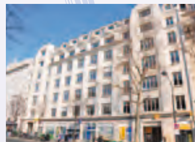
158/162, rue du Faubourg Saint-Martin Paris 10 e
