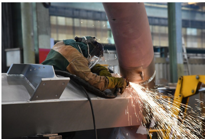
Fabrication de la Passerelle de Paris-Orly dans les ateliers du Groupe BAUDIN CHATEAUNEUF à Châteauneuf-sur-Loire (Loiret) ©Eric Dogniez
