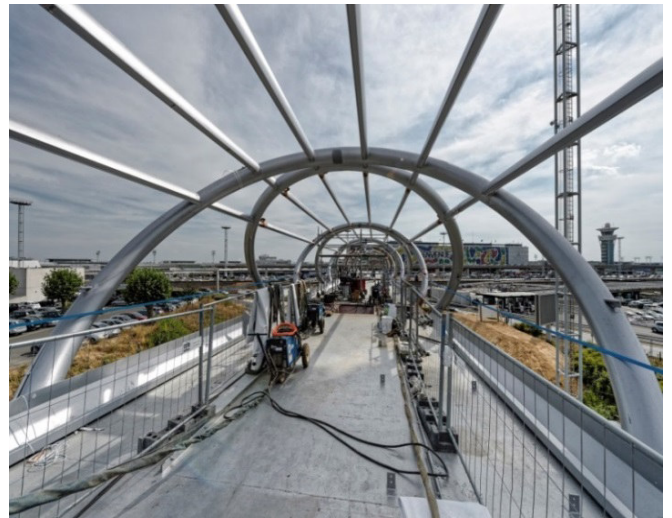
Intérieure de la passerelle en construction ©Groupe ADP - Alain Leduc
