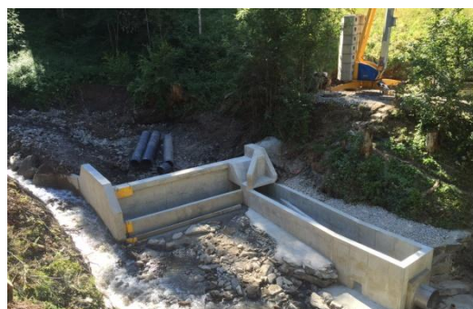
Travaux de génie civil de la prise d'eau de Samoëns
