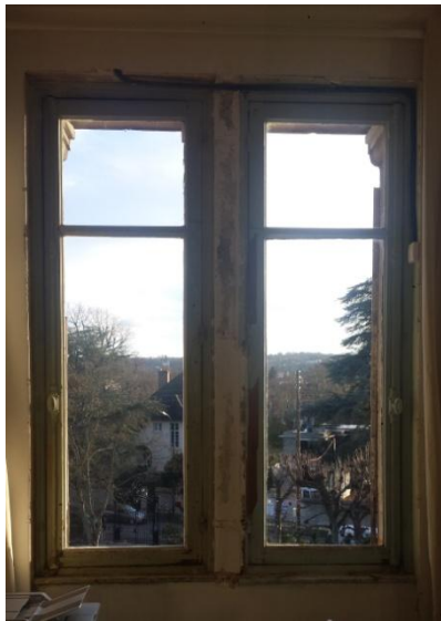
Menuiseries extérieures simple vitrage
