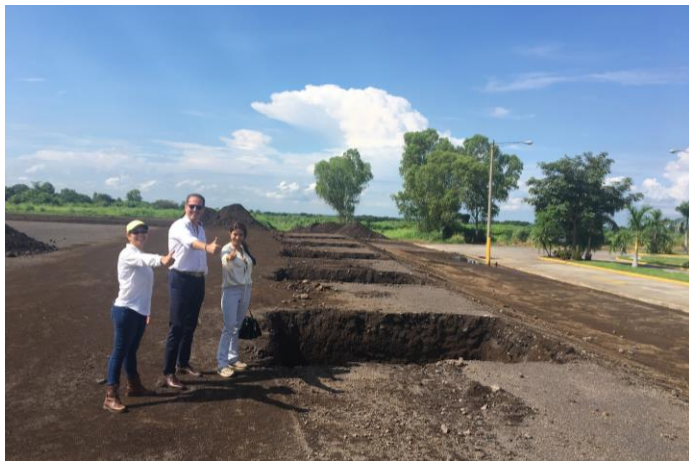
Début des travaux du nouveau site
