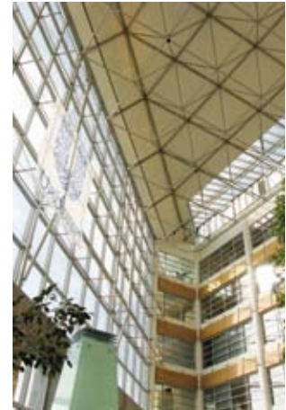
Diamond Building (Belgique)
