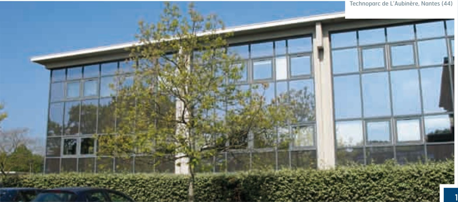
Technoparc de L'Aubinière, Nantes (44)
