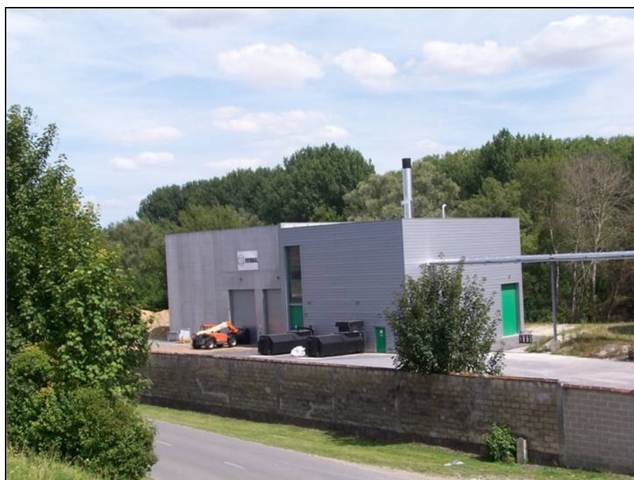
Bâtiment abritant la chaudière biomasse - EVERBAL
