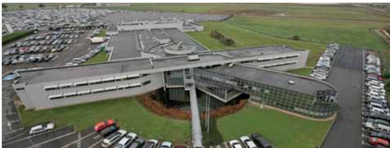
Technofan, siège social à Blagnac (31)
