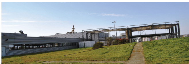
Travaux d'extension des bâtiments- Technofan SA
