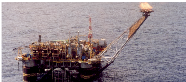
Brésil - Base logistique à Macaé / Brésil - Bassin CAMPOS
