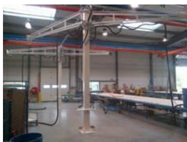
Chantier 5S Murs Mise en place de 6 potences pour supprimer les tuyaux air et aspirations au sol
