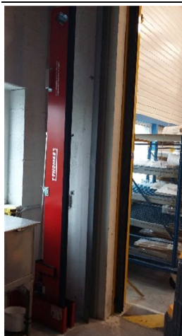
Barrières antipollution mises en place sur les sites de Cholet et du Poiré
