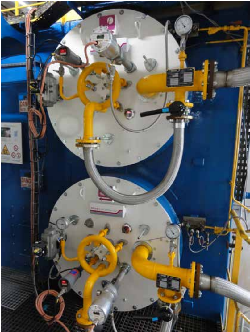
Nouveaux brûleurs bas NOx sur une des chaudières des Papeteries de Clairefontaine.
