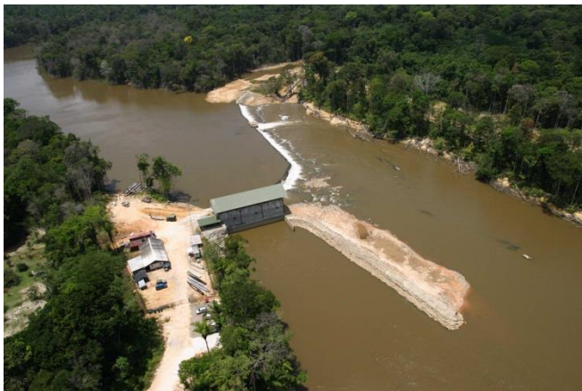
4. CENTRALE HYDRO-ELECTRIQUE DE MANA (GUYANE FRANÇAISE)
