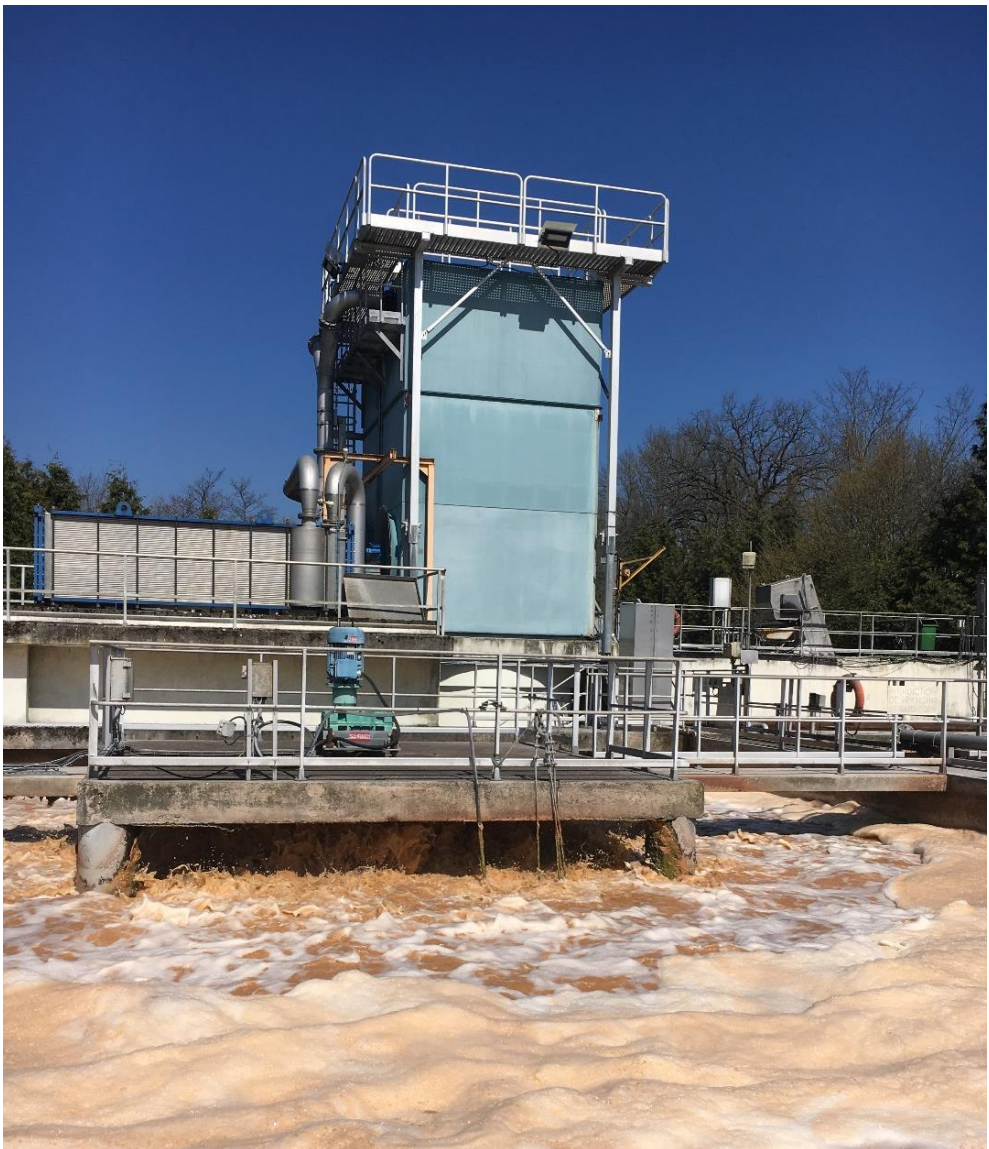
Aperçu de la station d'épuration des Papeteries de Clairefontaine
