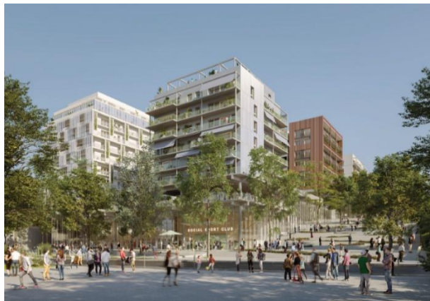
Vue de la façade Seine avec le Social Sport Club (Architectes UAPS, Brenac & Gonzalez & Associés)
