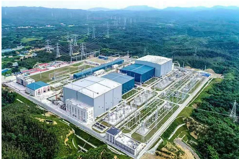
Station de conversion de la région de la Grande Baie
