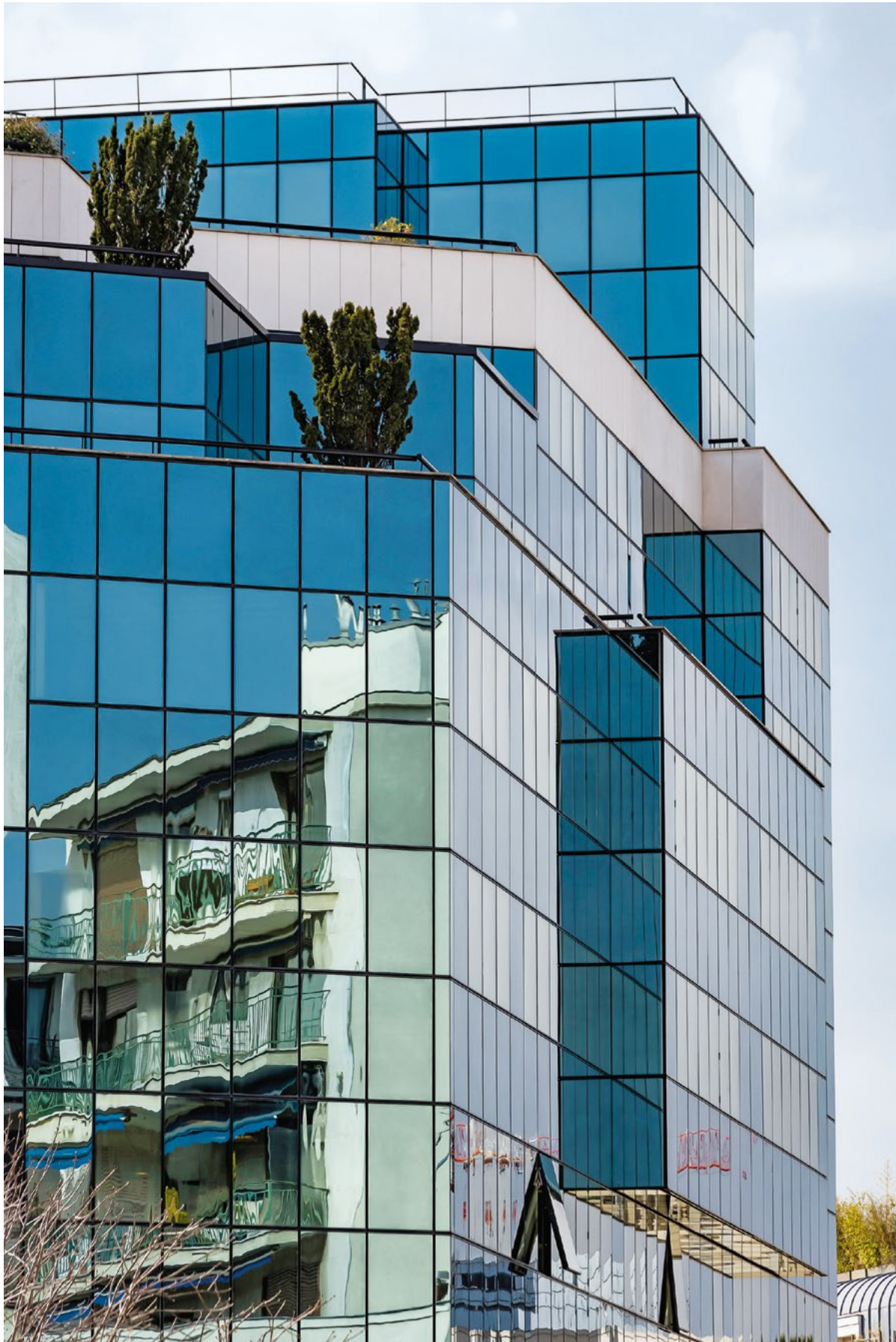
Immeuble Sofiparc de Levallois (Ile-de-France)
