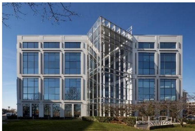
Immeuble Amsterdam sur le Parc Paris Orly-Rungis
