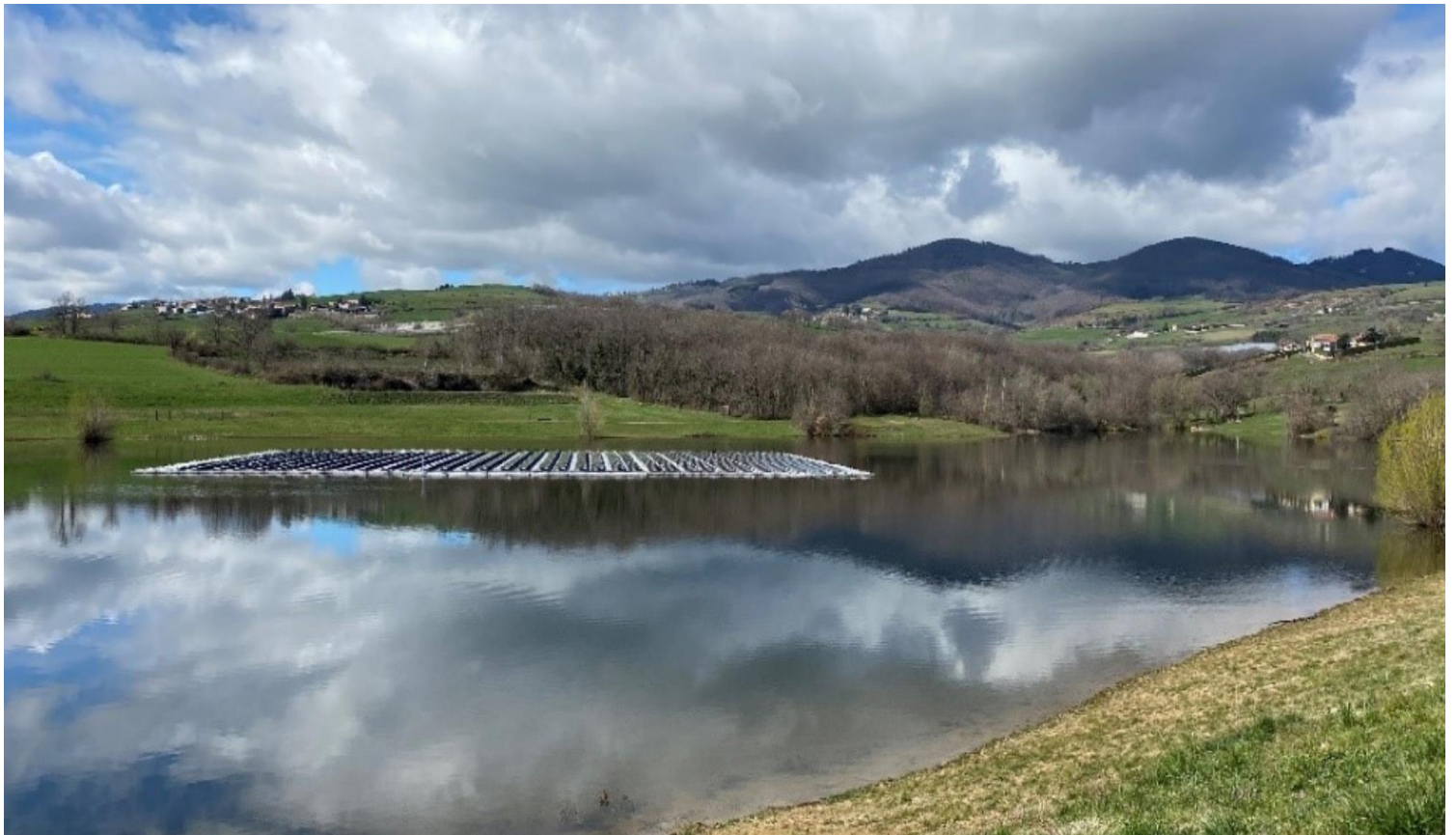
Premier parc photovoltaïque flottant de CNR (Compagnie Nationale du Rhône)
