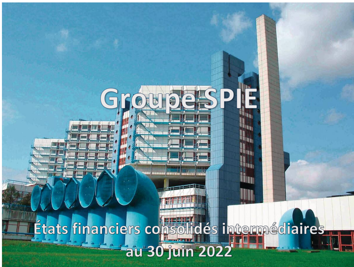
Installation de cogénération à Bruderwald en Allemagne
