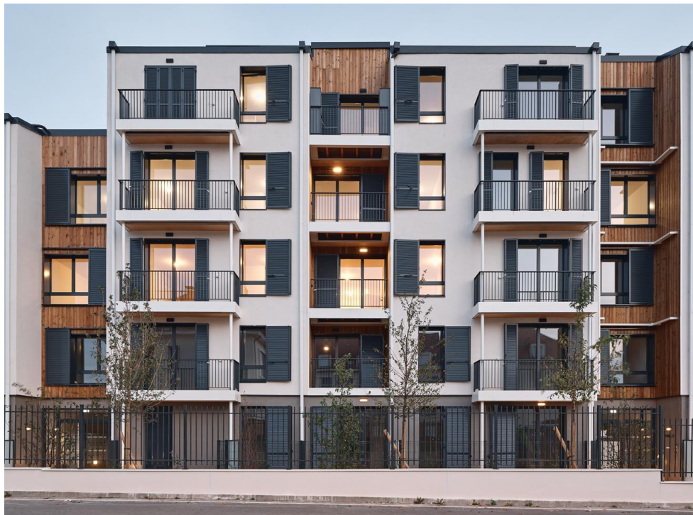
Immeuble « Melia », Taverny (95). Conforme au seuil 2031 de la RE2020 sur le critère carbone.
